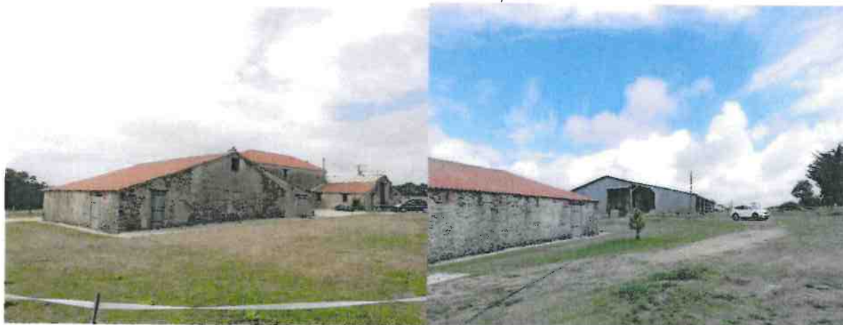
Photos des bâtiments repérés
