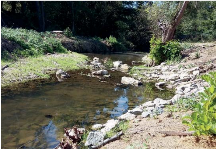
Un exemple de travaux réalisés : la renaturation du Ligneron
