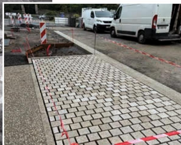
◀ Mise en place des stationnements en pavés joints verts. Agencement favorisant la récupération des eaux de pluie et la désimperméabilisation des sols afin de restituer l'eau dans les nappes et de limiter le ruissellement.
