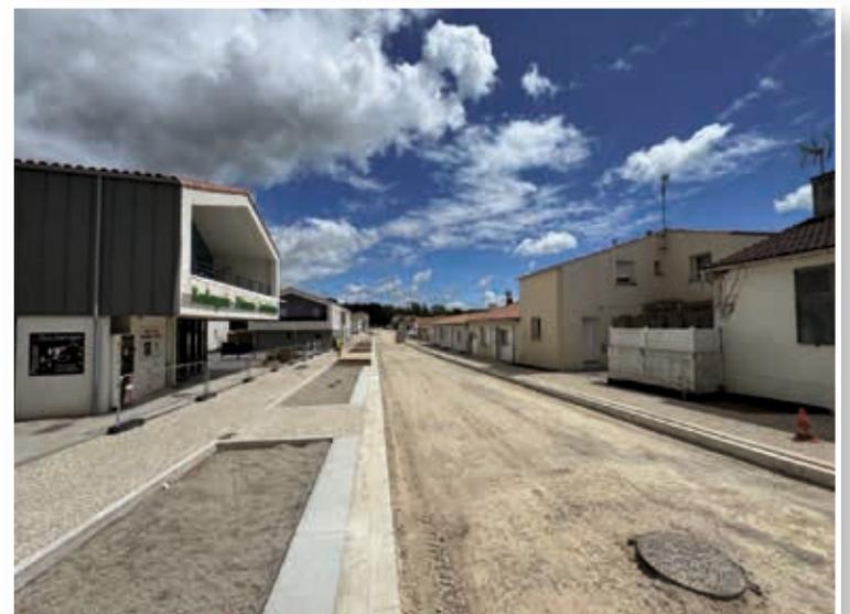
▲ Préparation des couches de formes sous la voirie et coulage des supports des plaques « arrêt minute » sur les stationnements devant les commerces. Une peinture provisoire sera mise en place pour la saison estivale, les plaques acier définitives avec l'inscription « arrêt minute » seront installées à la rentrée.
